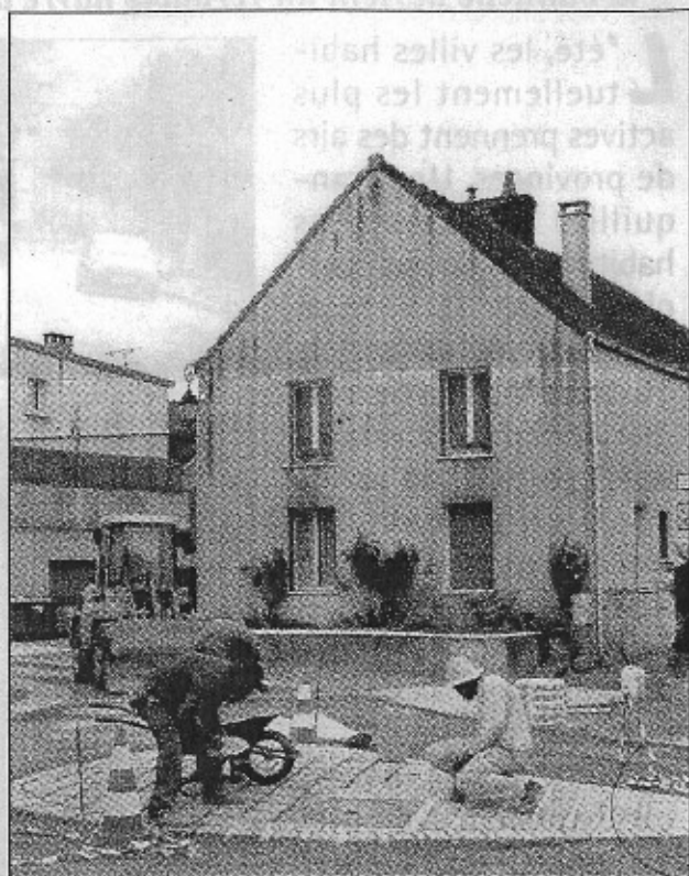
Les travaux rue du Bois clair
